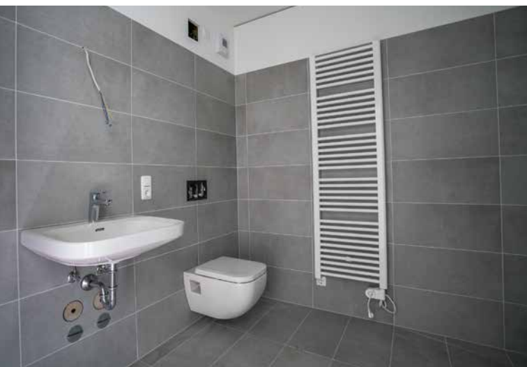
• Badezimmer kurz vor Abschluss der Fertigstellung
