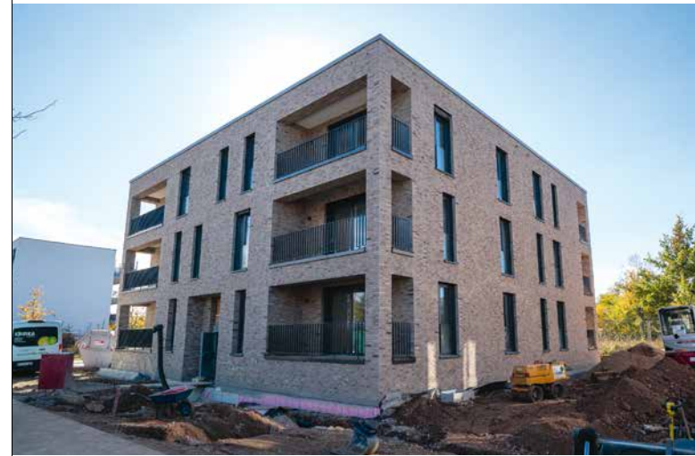
• Umfangreiche Tiefbauarbeiten sind für die Erschließung des Gebäudes notwendig
