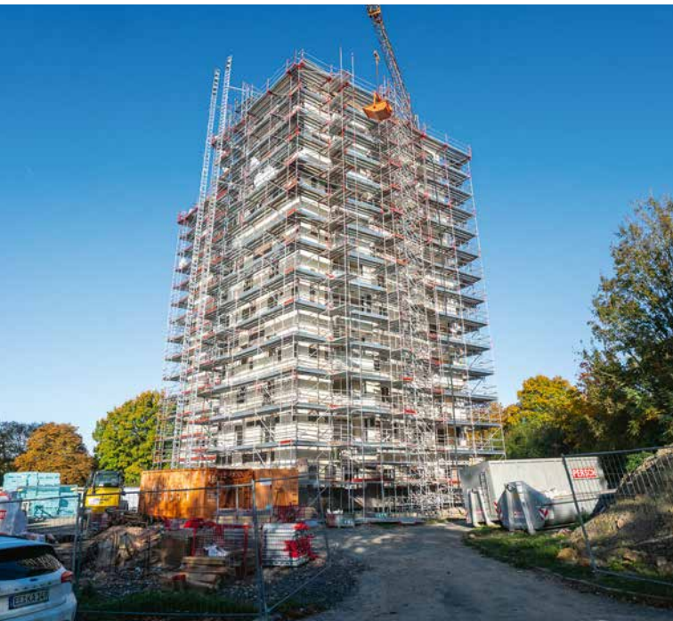
➤ Bereits von Weitem ist die Baustelle deutlich zu erkennen
