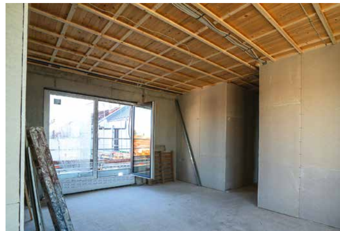
• Innenausbau mit Trockenbauwänden und Abhängung für Deckenverkleidungen
