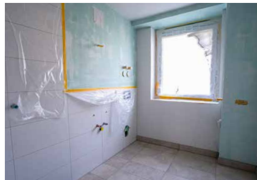
➤ Vorbereitungen für die Malerarbeiten im Bad
