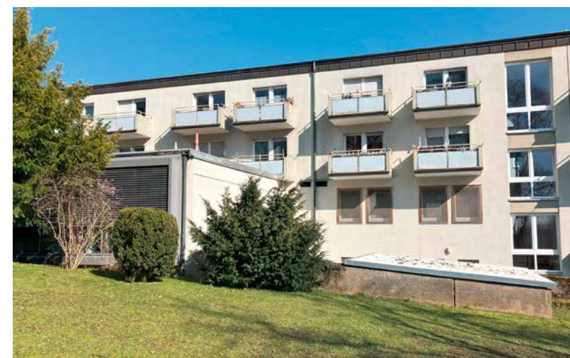
➤ An den Brennöfen 10 – Rückseite mit Gewerbeanbau
