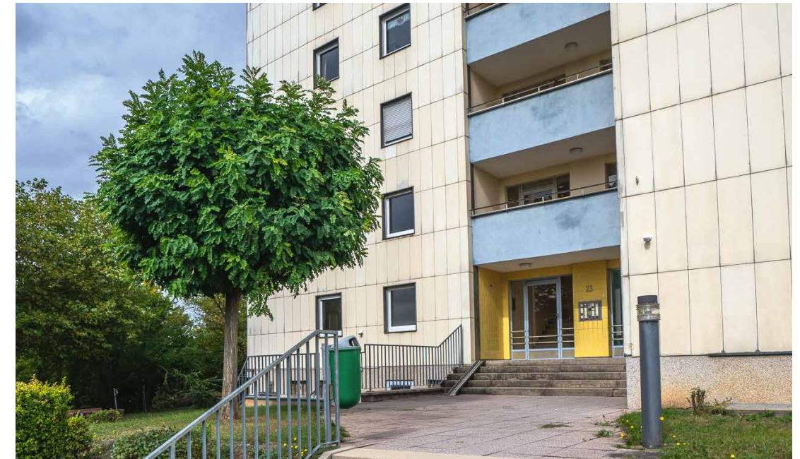
➤ Blick auf den Gebäudehaupteingang vor der Modernisierung
