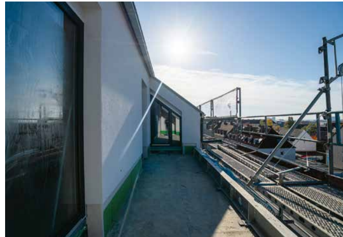
• Blick auf einen Dachbalkon noch während der Bauphase
