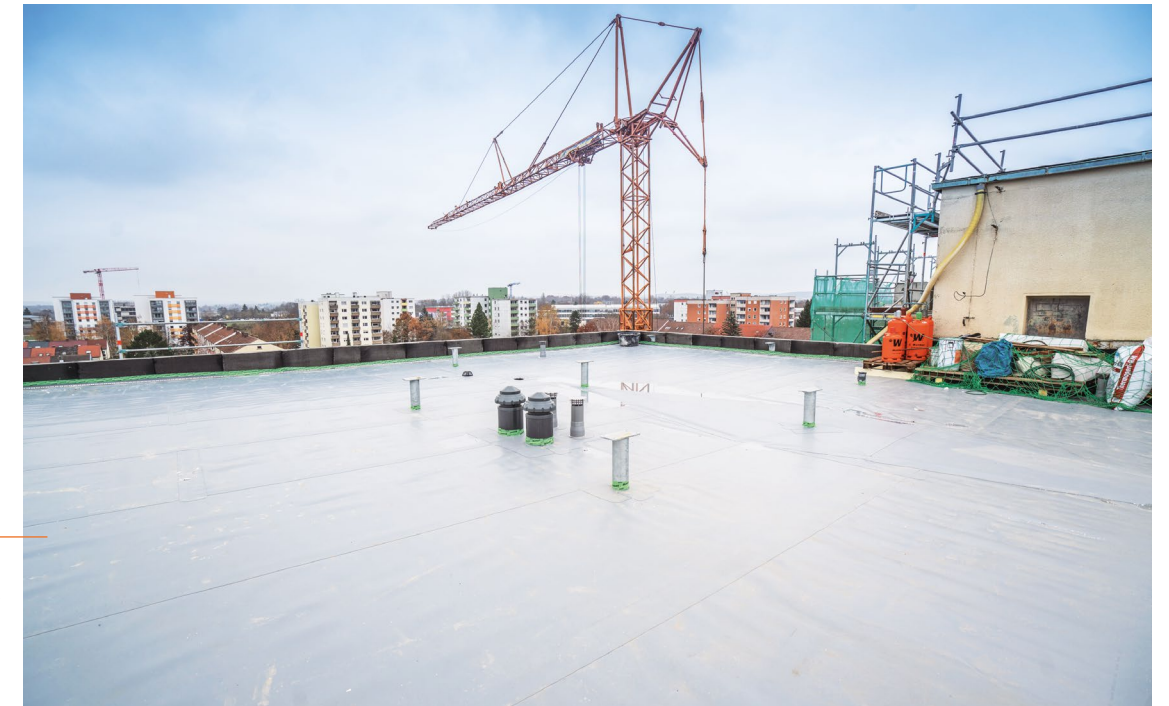
Neue Flachdachkonstruktion mit Folienabdichtung
