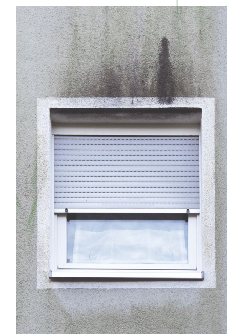
Fassade vor der Reinigung
