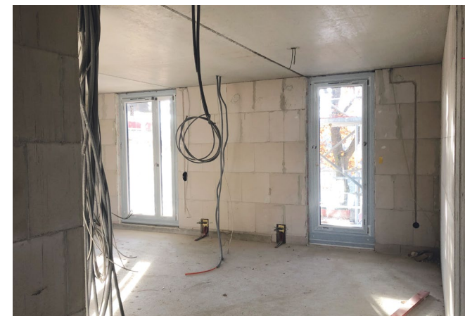
Erste Installationsarbeiten für die Haustechnik
