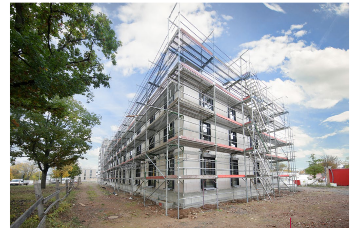
Das Arbeitsgerüst ist aufgebaut; die Arbeiten an der Fassade können starten
