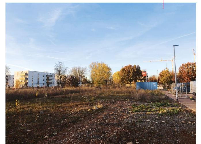
Das geräumte Grundstück steht für den Baustart bereit
