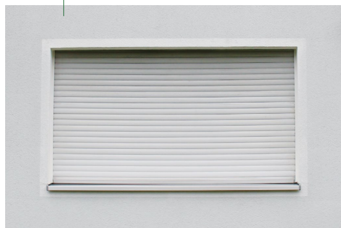
Fassade nach der Reinigung
