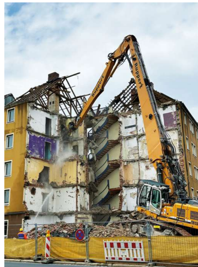
Vorsichtig wurde das vorhandene Gebäude mit schwerem Gerät abgebrochen
