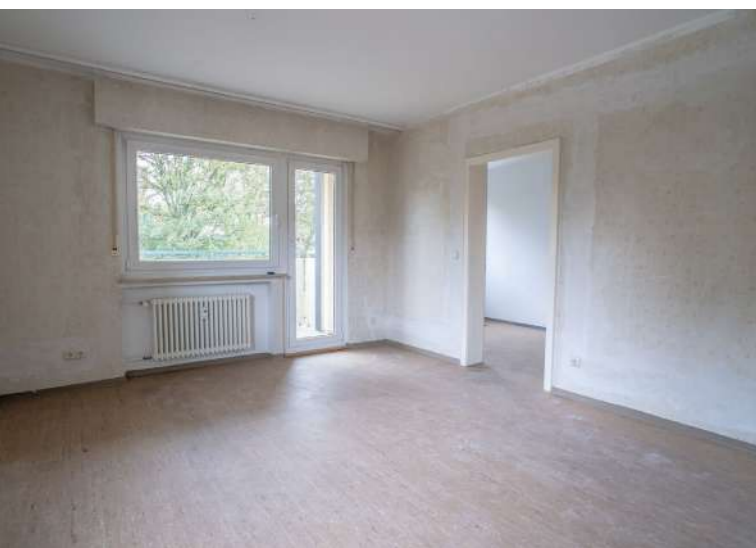
Leerwohnung mit Ausstattung und Oberflächen aus der Bauzeit
