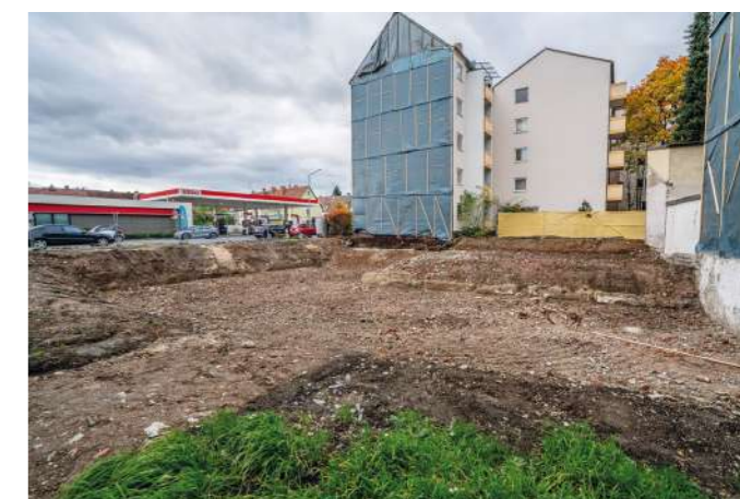
Das Grundstück ist für den Neubau vorbereitet
