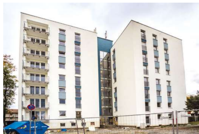
➤ Das modernisierte Gebäude ist bereits von weitem durch neue Farbakzente in der Fassade zu erkennen
