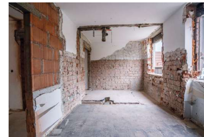
➤ Innenwände, Wand- und Bodenbeläge sind bereits entfernt und neue Türöffnungen hergestellt
