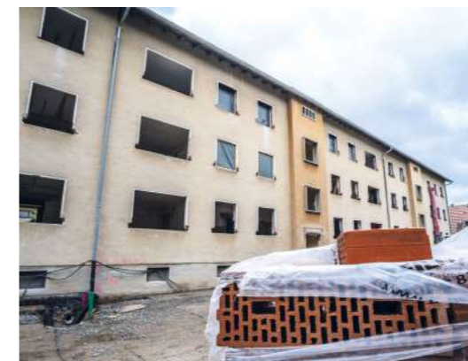
➤ Rückbau auf Rohbauniveau
