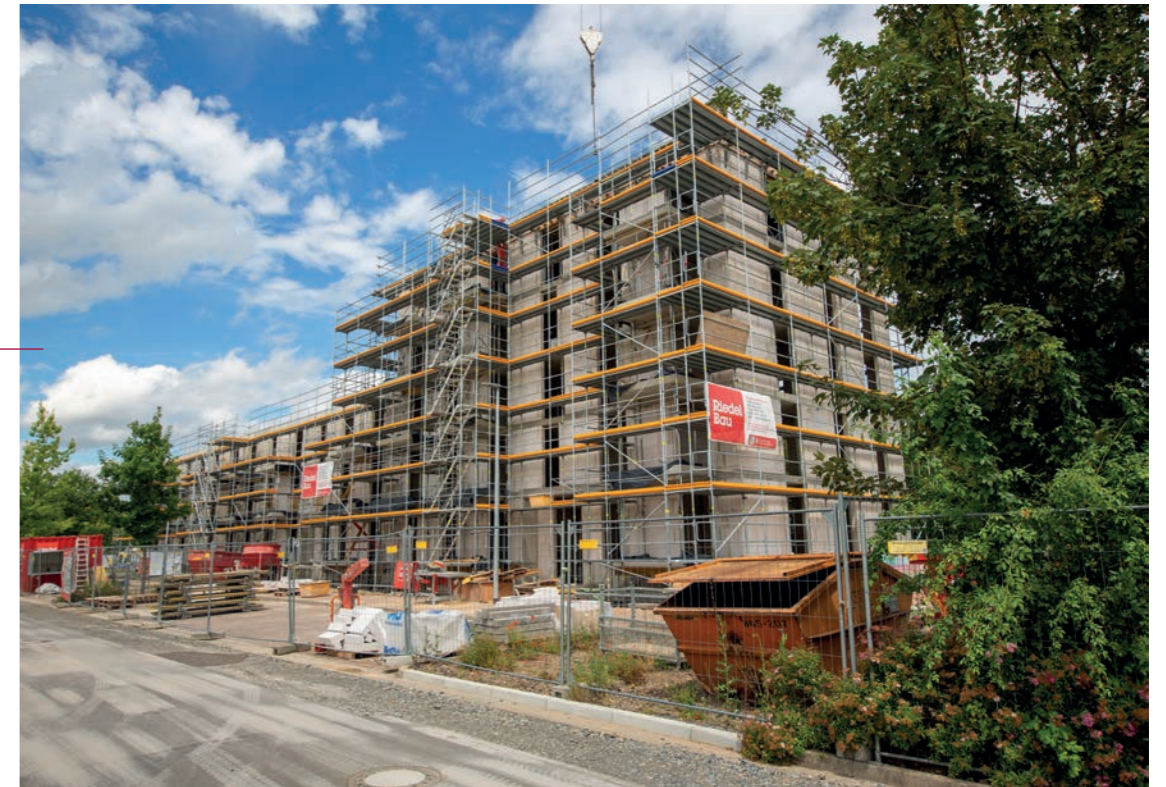
Gebäude nach Fertigstellung des Rohbaus im August 2020
