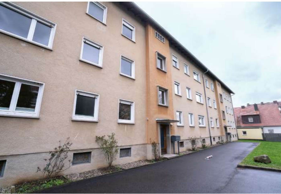
› Innenhof und Fassade des Bestandsgebäudes vor Beginn der Modernisierung
