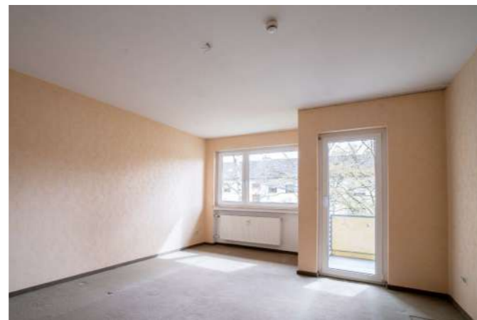
› Neue Fenster und Heizkörper tragen u. a. zur Erreichung des geplanten Effizienzhaus Standards nach der Modernisierung bei
