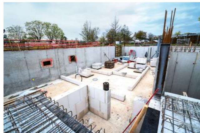
Die tragenden Innenwände im Untergeschoss werden in Mauerwerk hergestellt
