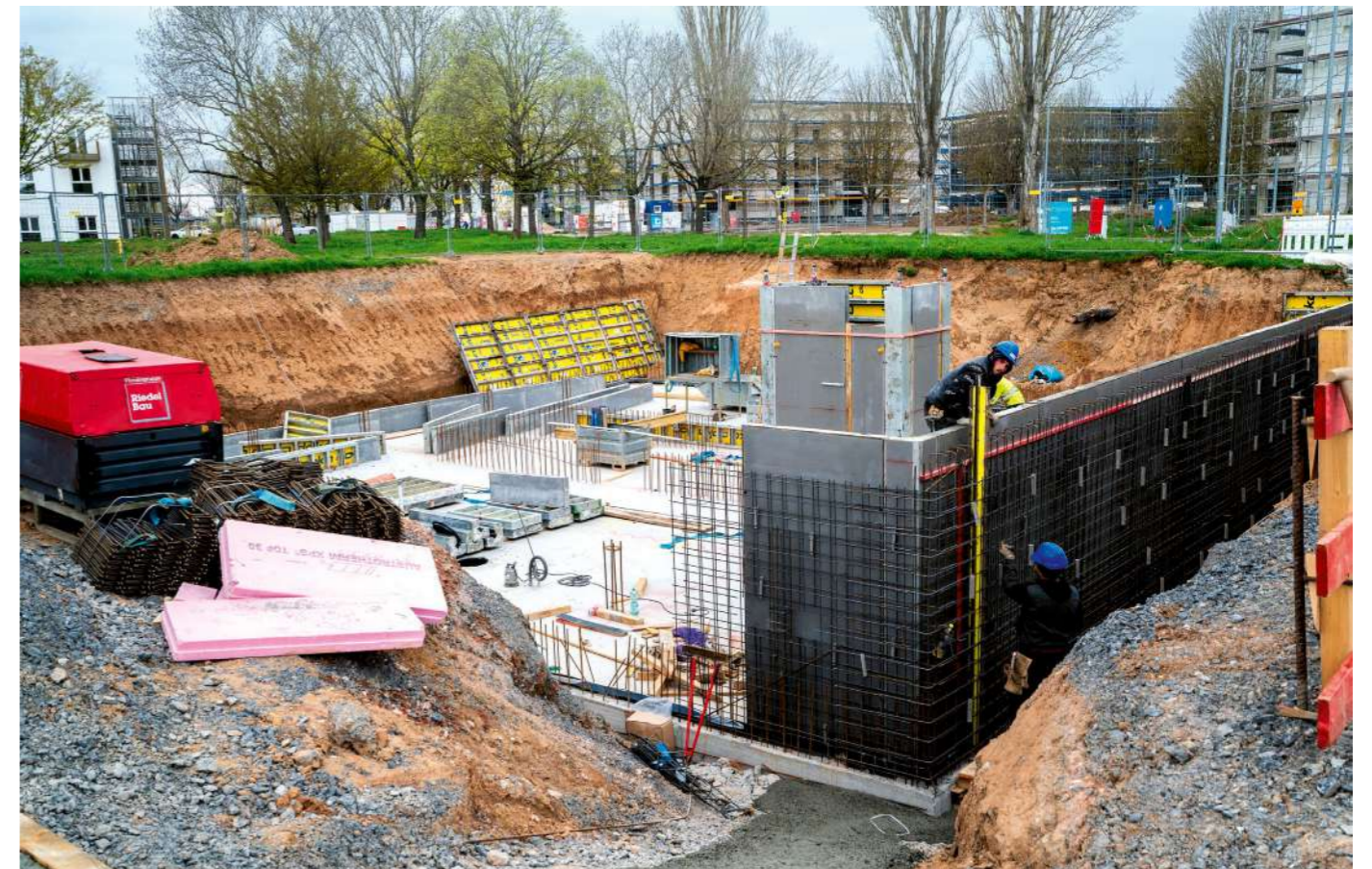
Die verbaute Stahlarmierung sorgt in Verbindung mit der Betonfüllung für eine ausreichende Tragfähigkeit der Kelleraußenwände
