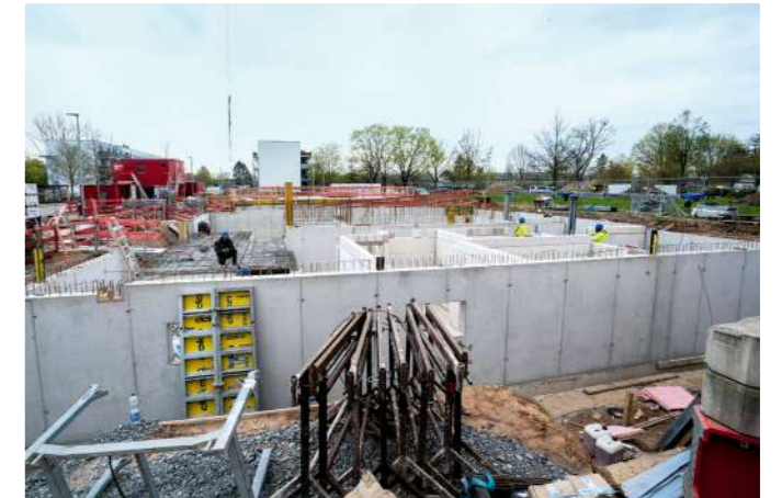
Die Stahlbeton- und Mauerwerksarbeiten im Untergeschoss sind weitgehend abgeschlossen, im nächsten Schritt wird die Kellerdecke erstellt
