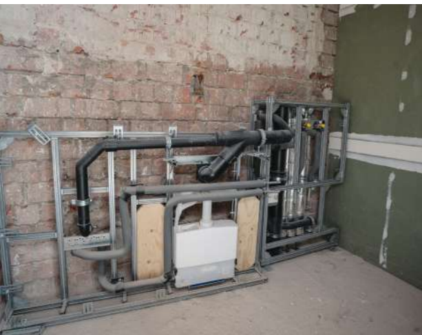
► Die vorgefertigten Installationselemente für die Haustechnik stehen zum Einbau bereit
