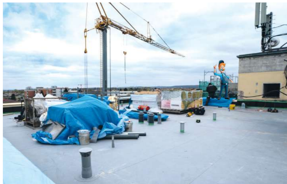
► Die vorgefertigten Installationselemente für die Haustechnik stehen zum Einbau bereit
