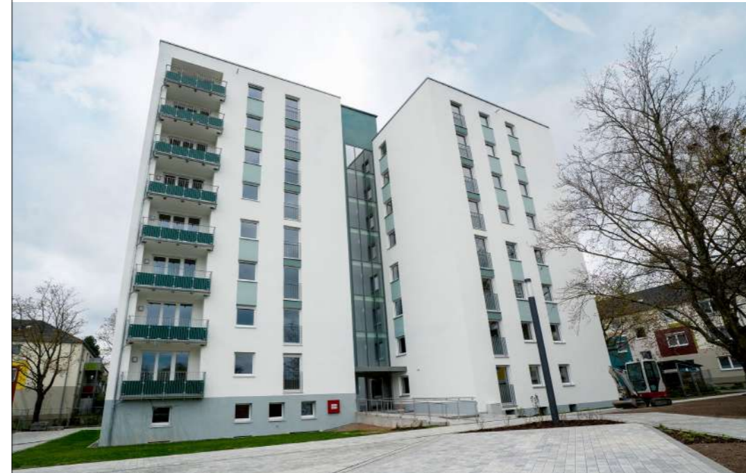
► Blick auf das Mehrfamilienwohnhaus nach Abschluss der Modernisierung im Innen- und Außenbereich
