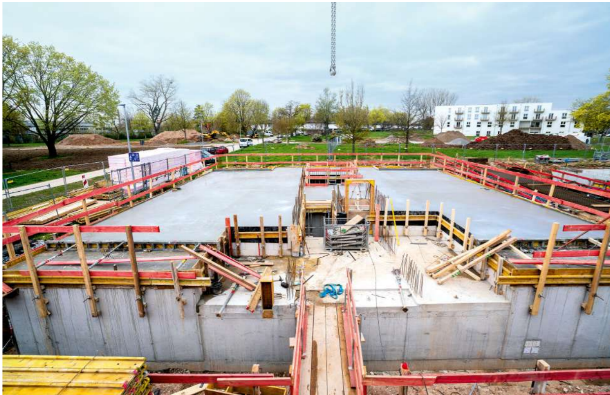
Die Decke über dem Kellergeschoss ist bereits betoniert. Bald können die Außenwände im Erdgeschoss errichtet werden
