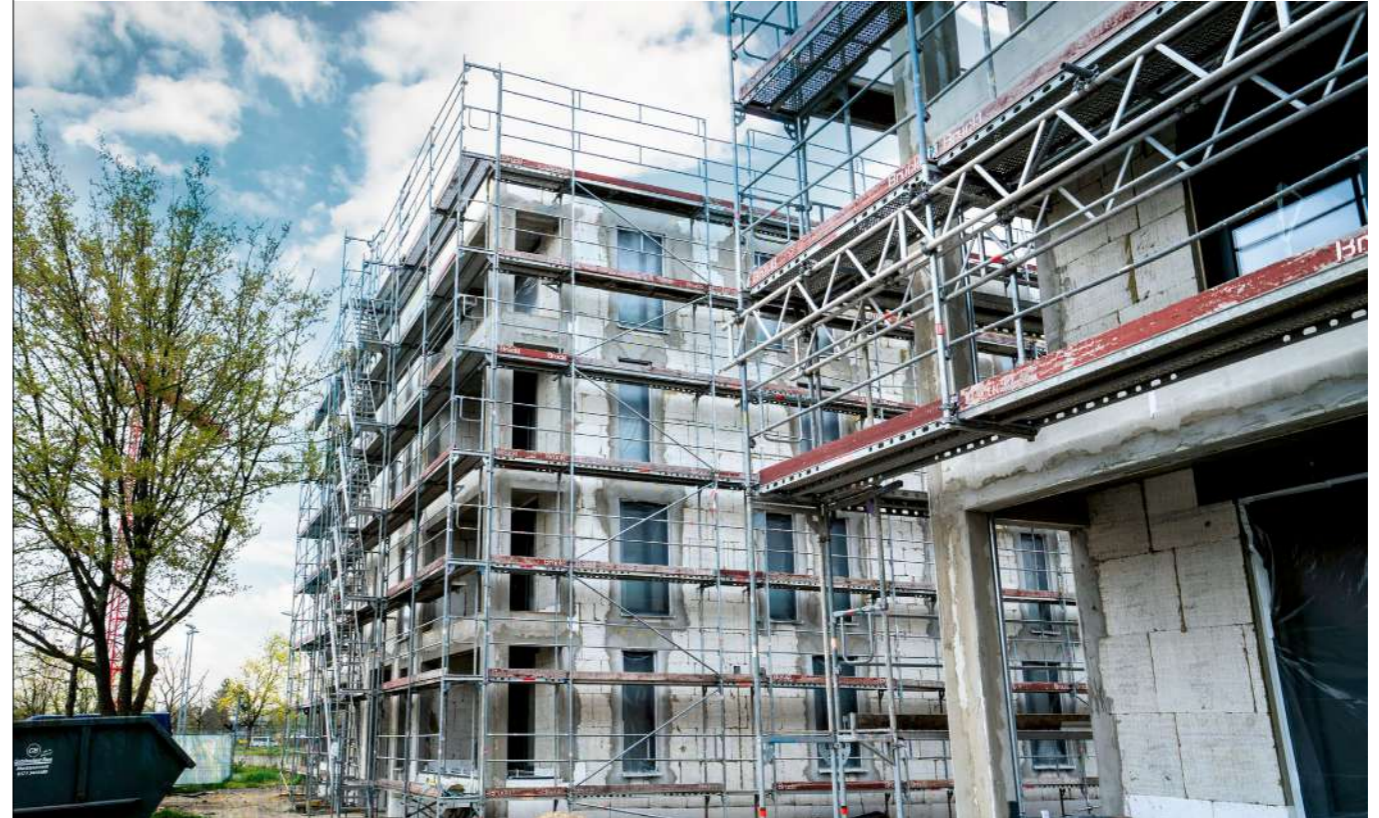
› Die Dämmung an den Außenwänden ist bereits vollständig eingebaut
