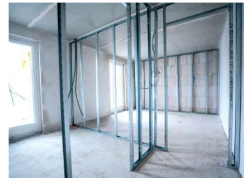
› Mit Trockenbauwänden werden die Wohnungsgrundrisse „geformt“
