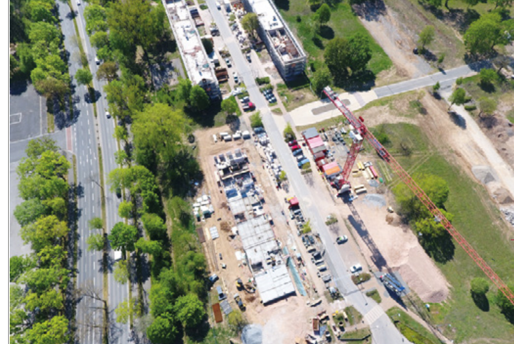
Die Baustelle aus der Vogelperspektive, im Vordergrund Rohbau 1. Bauabschnitt
