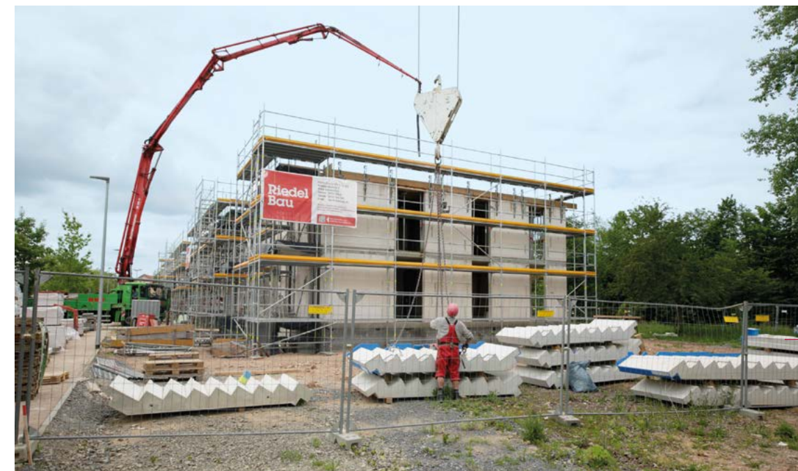
Rohbau Erdgeschoss und 1. Obergeschoss. Im Vordergrund: Versetzen von Treppenläufen
