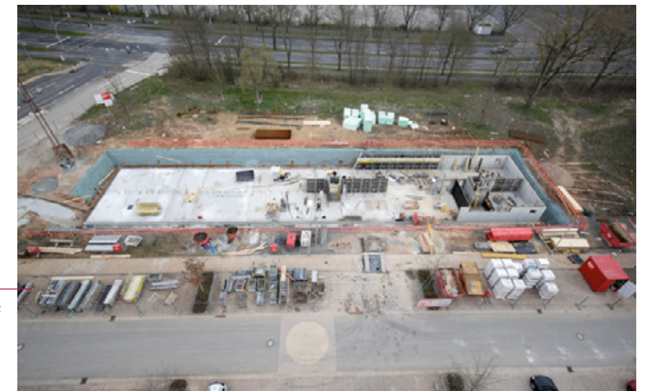
Bodenplatte und Kellergeschoss
