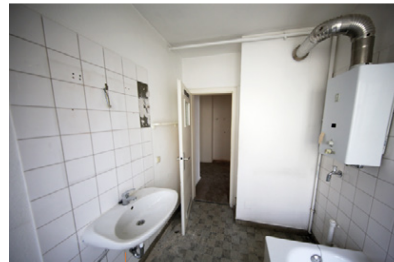
Bad vor der Modernisierung
