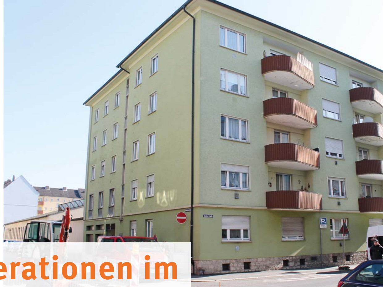
Theresienstraße 19 vor der Modernisierung
