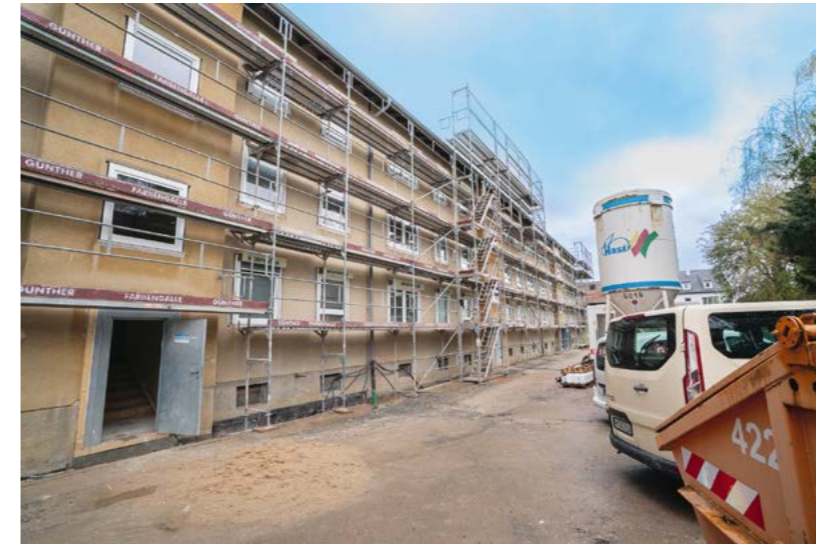
➤ Innenhof-Fassade mit dem Arbeitsgerüst für die anstehenden Wärmedämm-Verbundsystem-Arbeiten
