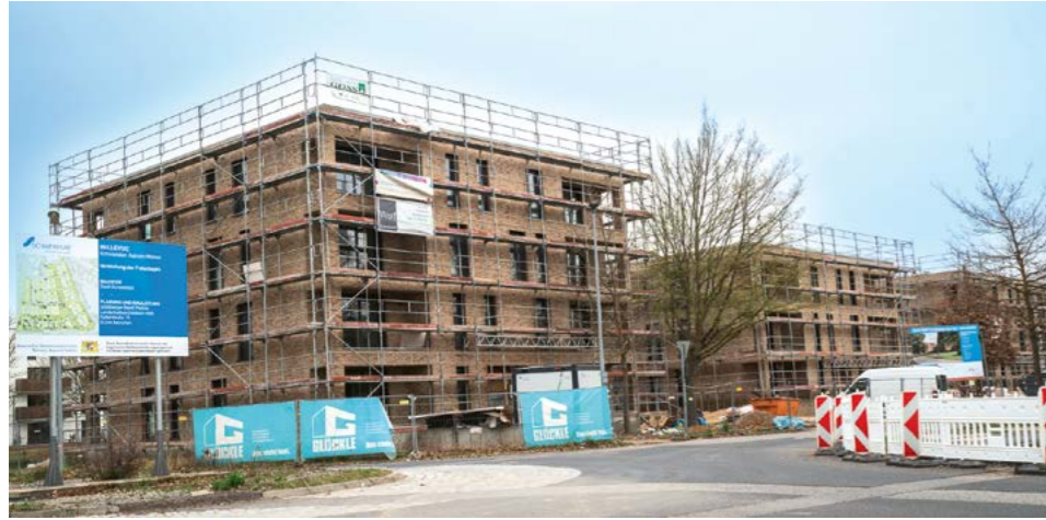
Die Klinkerriemchen-Fassade ist fertig gestellt; letzte Arbeiten an den Loggien stehen noch aus
