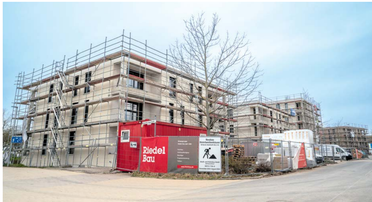
↳ Blick auf den 4. Bauabschnitt in der Wilhelm-Kohlhoff-Straße
