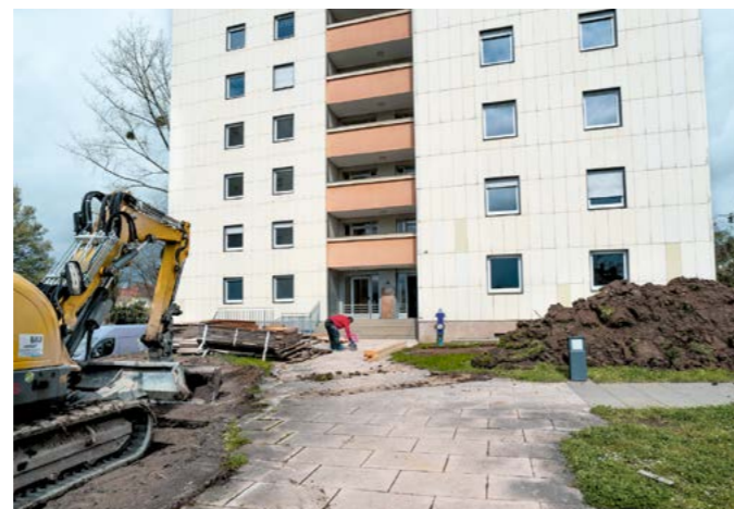
➤ Der vorhandene Oberboden wird abgetragen und seitlich zum Wiedereinbau gelagert
