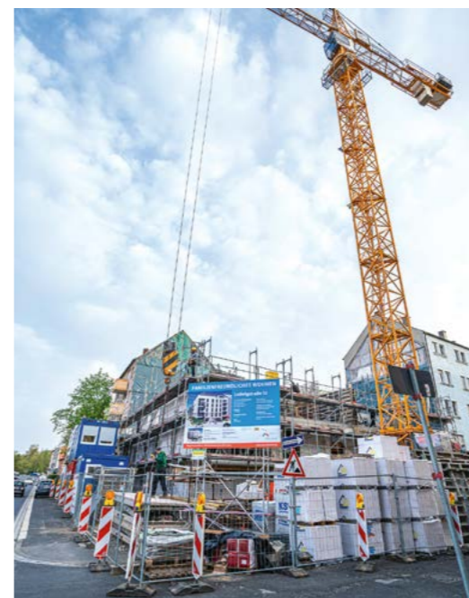
➤ Die geringen Lagerflächen auf der Baustelle sind eine besondere Herausforderung für die Handwerker
