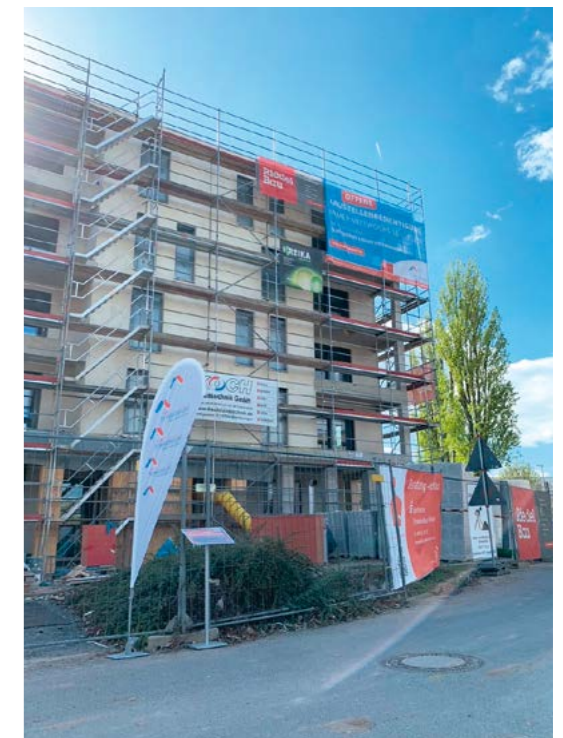
▶ Offene Baustellenbesichtigung am Haus der Wilhelm-Kohlhoff-Straße 2
