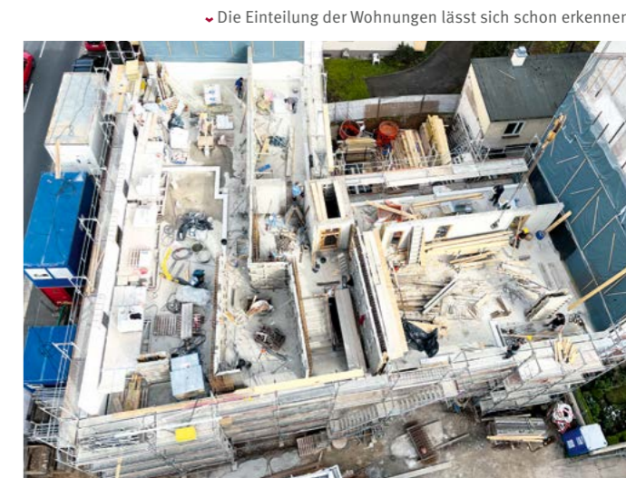
➤ Die Einteilung der Wohnungen lässt sich schon erkennen
