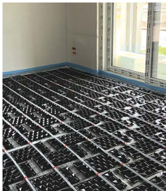
↳ Die Rohrleitungen für die Fußbodenheizung sind verlegt
