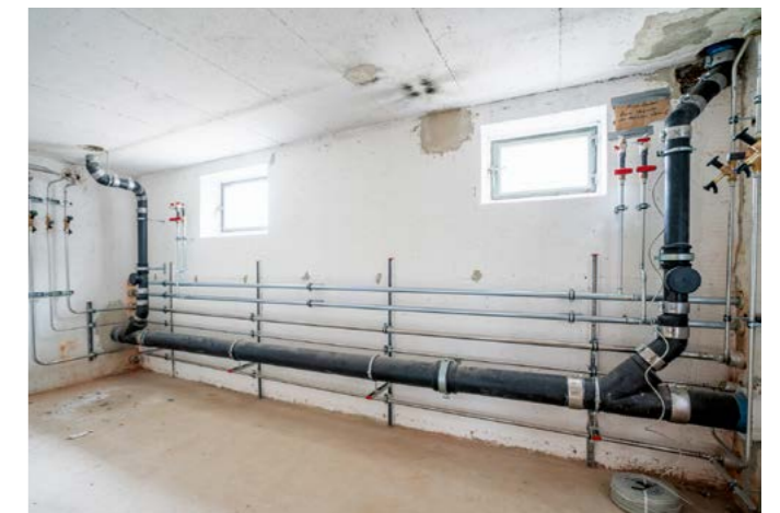
➤ Erste Ver- und Entsorgungsleitungen sind im Kellergeschoss bereits installiert
